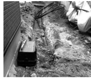
メーターBOXを取り付けています。
