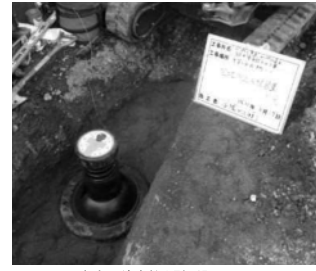
宅内に給水管を引き込みました。
